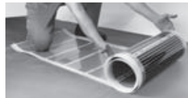
Рис. 3. Раскатывание рулона теплого пола на теплоотражающем материале
