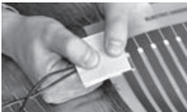
Рис. 14. Установка верхнего листа изоляции
