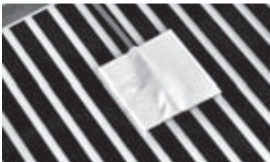
Рис. 17. Установленный и приклеенный датчик температуры пола. Вид снизу термопленки
